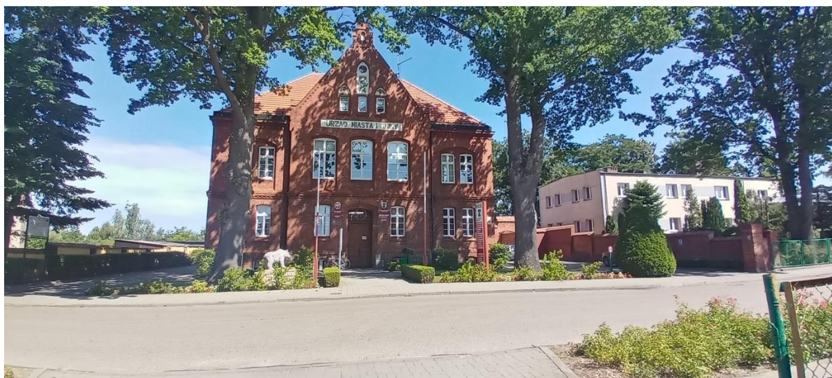
Zdjęcie 1 Parking i otoczenie wokół budynku
